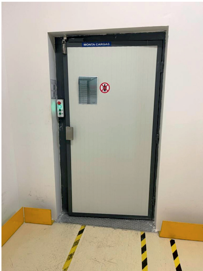
Plataforma com Fechamento em Alvenaria (Exterior) Platform with Masonry Closure (Outside)
