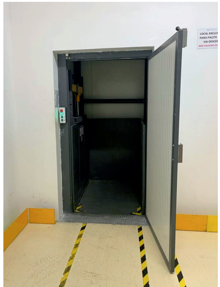
Plataforma com Fechamento em Alvenaria (Interior) Platform with Masonry Closure (Inside)
